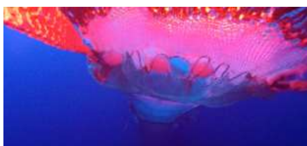
Bilde 15. Matten under og nettet i selve utslippseksjonen ble tredd sammen. Hensikten å stramme tauet med en stor fløyt kule.
